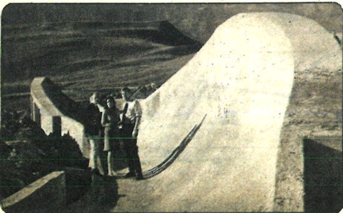
La pista olimpica di bob, presso il Colle di Pourtan all'Alpe d'Huez. È stata preparata questa estate, a tempo di record, con materiale prefabbricato.
